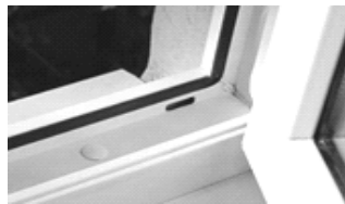
Дренажные отверстия в притворе окна
