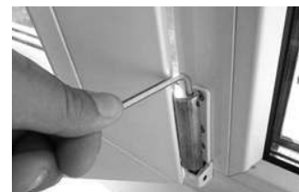
Рис. 7. Регулировка положения створки по вертикали
